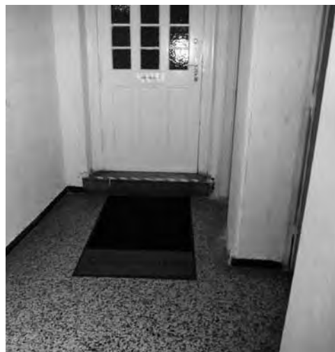
Hier soll eine Rampe gebaut werden.
